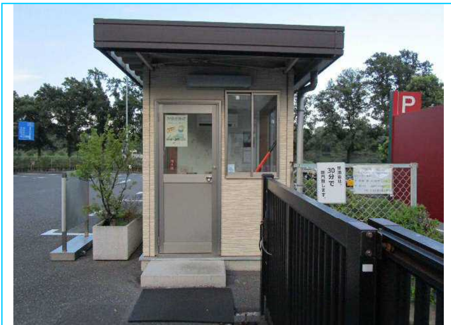
120 第一駐車場監視所 H=3.02m W=2.02m D=2.02m ※立面図有り
