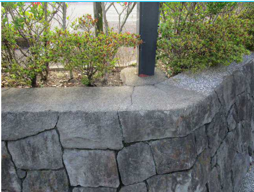
83 石積擁壁天端
