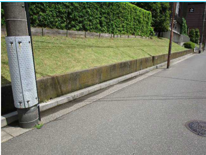
24 コンクリート土留
