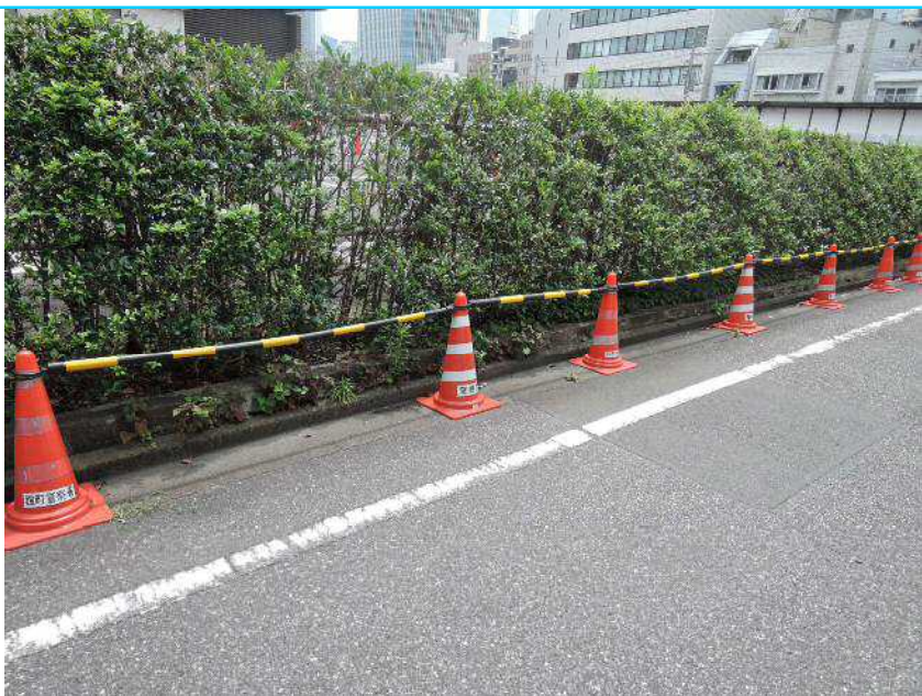
95 コンクリート土留
