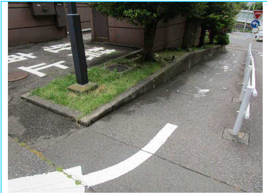
29 コンクリート土留
