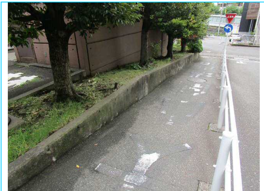
29 コンクリート土留
