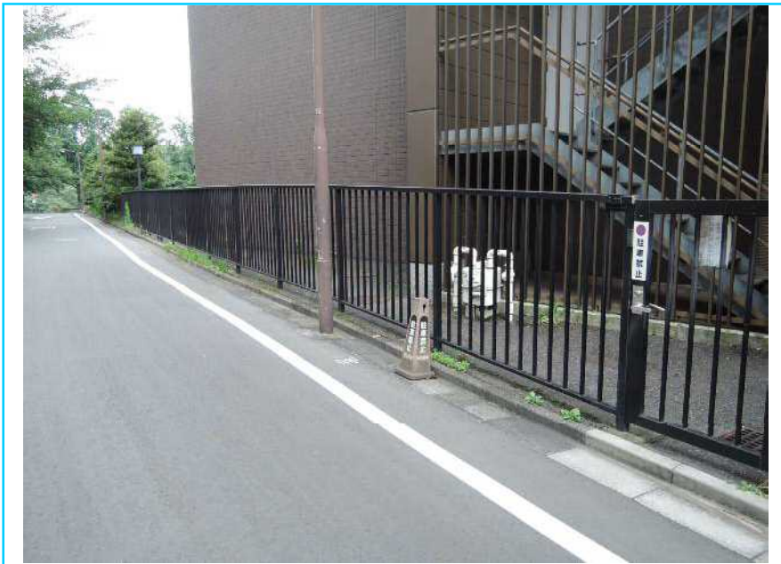
85 縦格子アルミフェンス H=1.50m~1.55m L=61.34m
