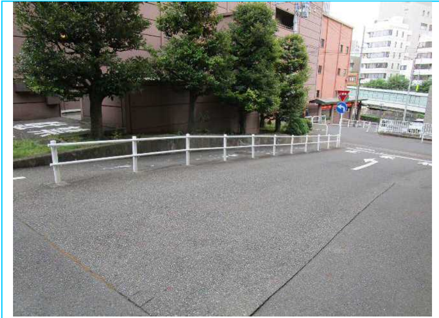
28 ガードパイプ
