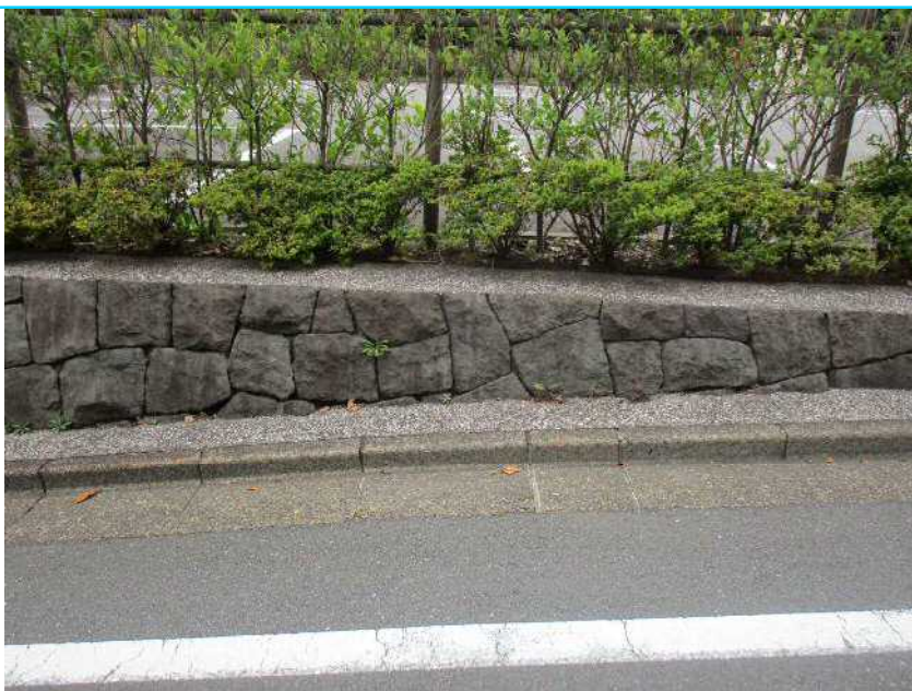
83 石積擁壁D面
