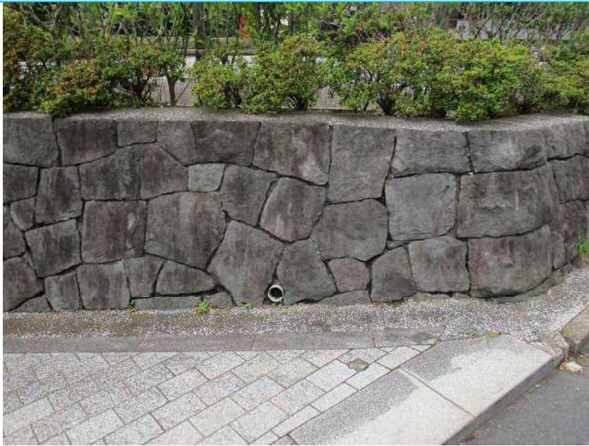
83 石積擁壁C面
