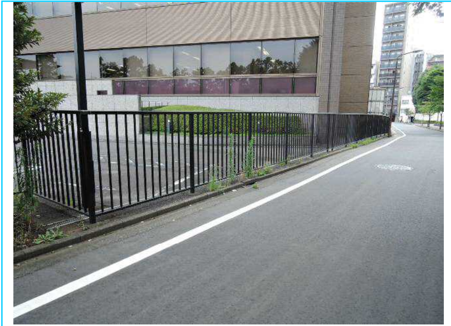
85 縦格子アルミフェンス H=1.50m~1.55m L=61.34m
