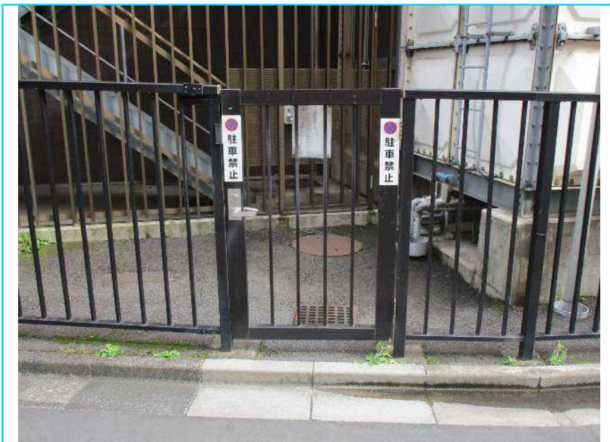
86 縦格子片開きアルミ門扉 H=1.50m W=0.92m
