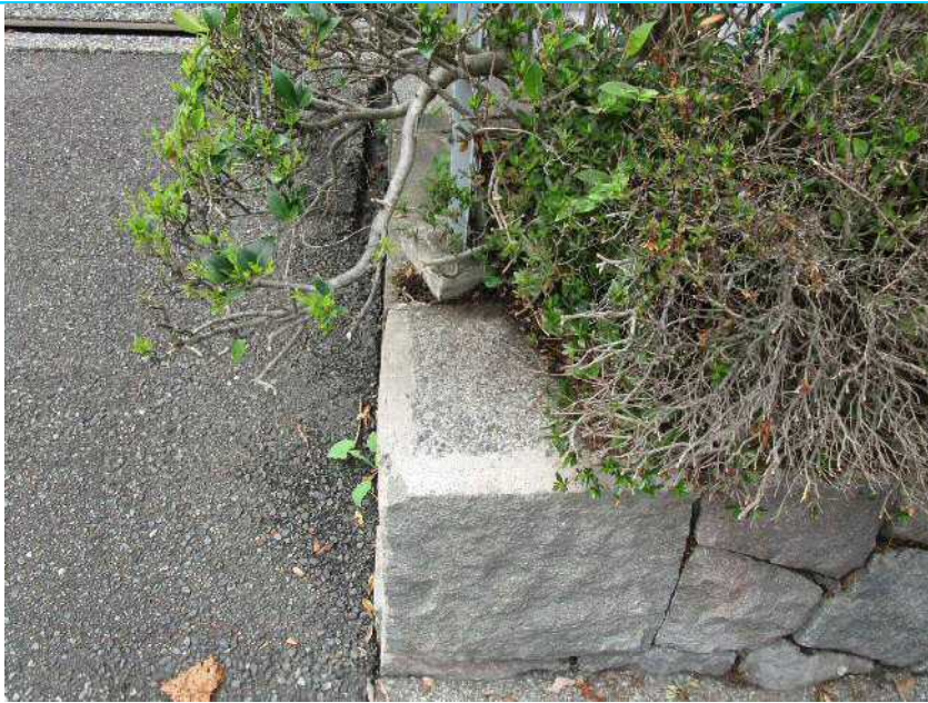
83 石積擁壁天端
